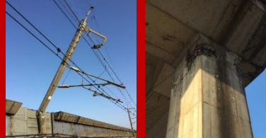
電柱の折損 橋脚の損傷
