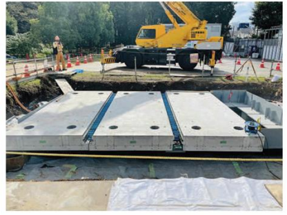
写真2 プレキャスト床版設置完了
