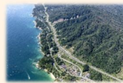
三陸沿岸道路 (岩手県山田町)
