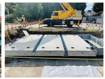
写真2 プレキャスト床版設置完了
