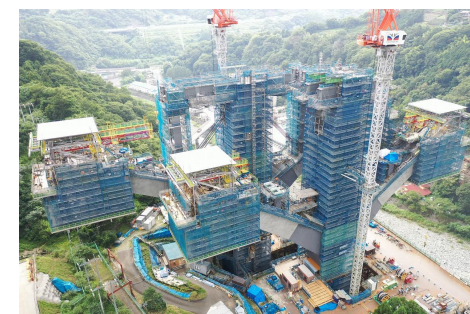
山間部でのアーチ橋の施工
