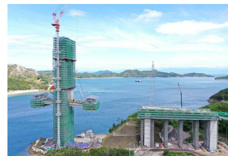
大スパンの斜張橋の施工
