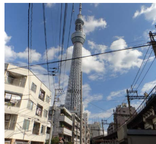
【東京都墨田区】 蜘蛛の巣状の電線がスカイツリーの 外観を損ねている。
