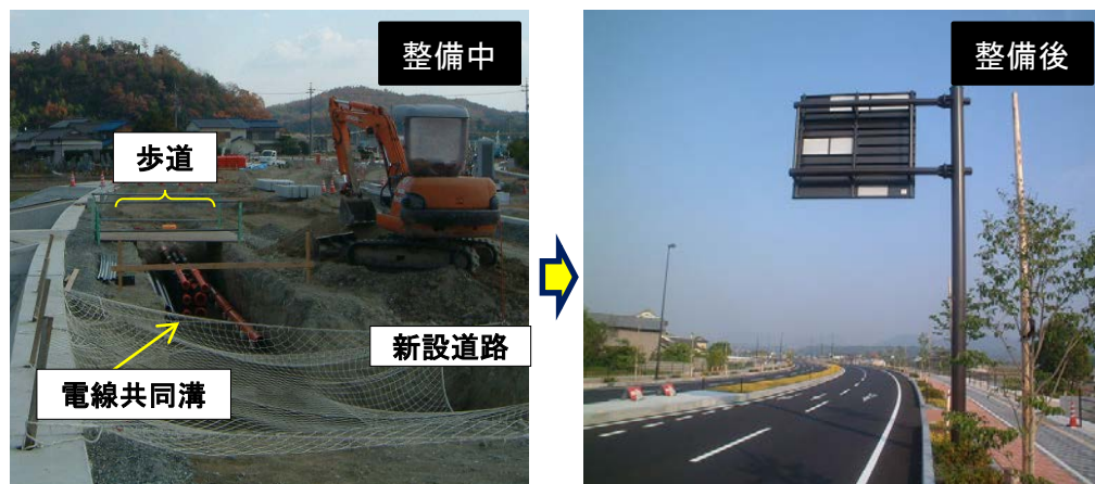
岡山県岡山市(国道180号総社・一宮BP)
