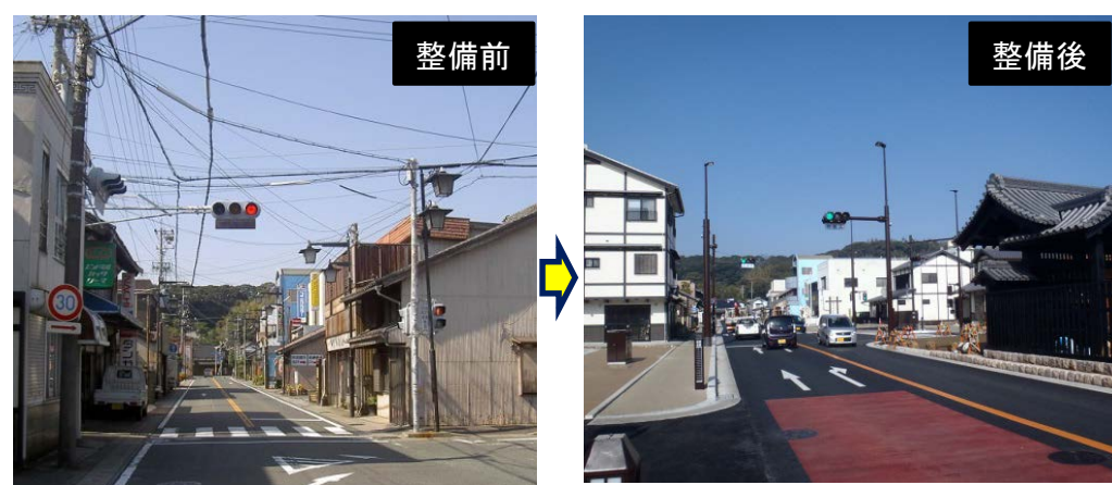
静岡県湖西市(国道301号歩道整備)
