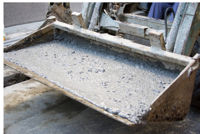
台湾：CLSMを利用した埋め戻し
