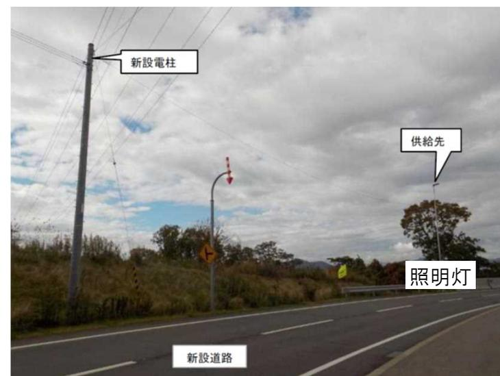
〔 新設道路に必要な照明への電力供給のため電柱が新設 〕
