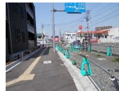
常設作業帯を確保し昼間で施工
