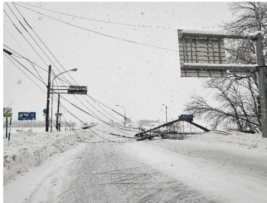
令和4年12月 暴風雪による電柱倒壊(R4.12.23)
