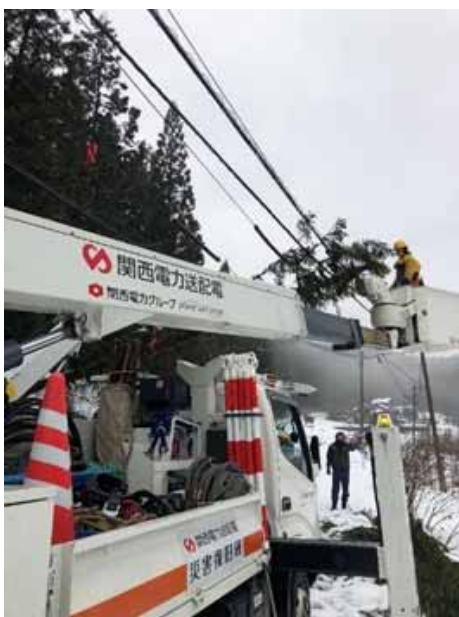
電線に接触した樹木の除去作業の様子 (関西電力送配電)
