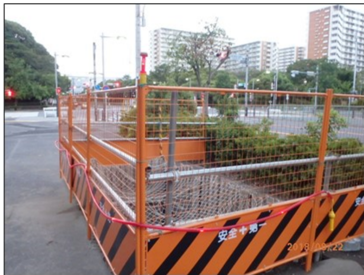
港湾局大井2号 (電線共同溝工事)
