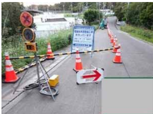
小笠原諸島（母島） 都道第241号 (電線共同溝工事)
