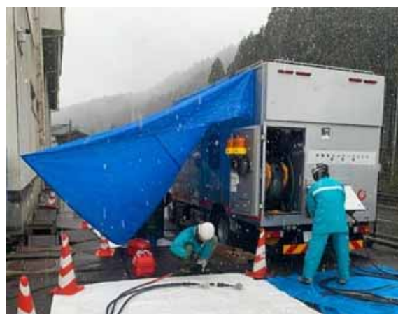
電源車から避難所への送電作業の様子 (中部電力パワーグリッド)
