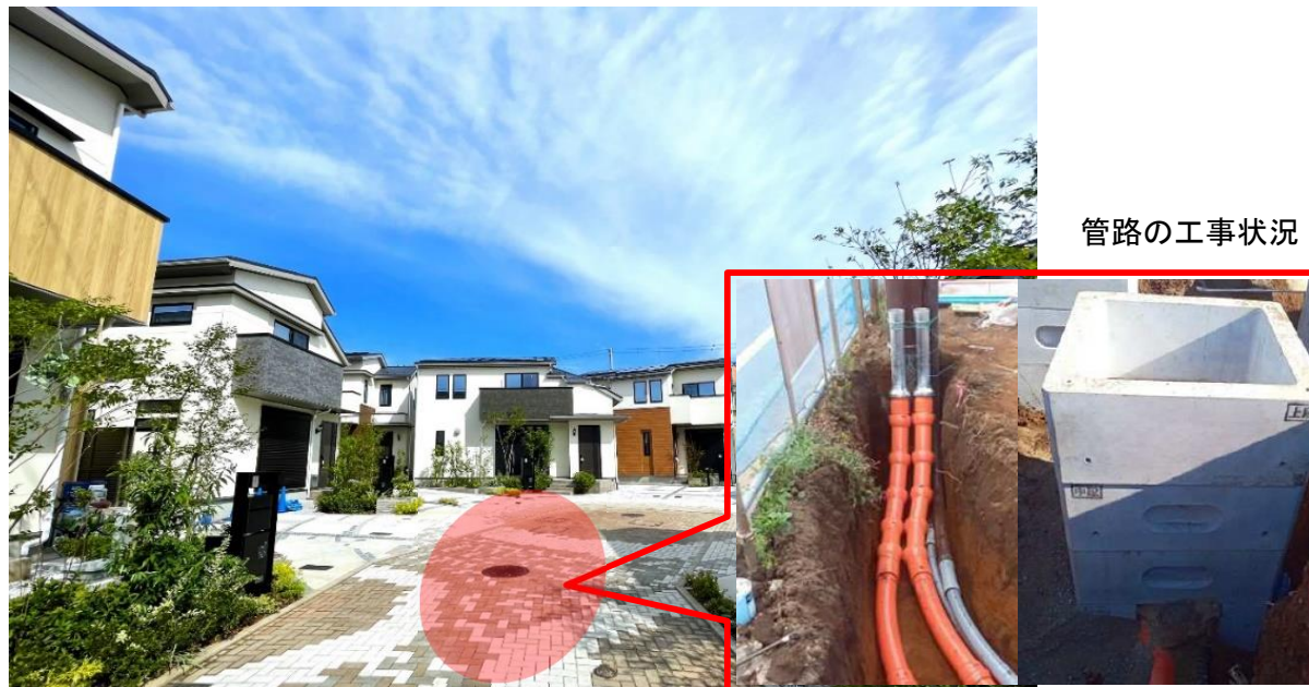
無電柱化まちづくり促進事業を活用した 無電柱化の実施事例 (東京都狛江市)
