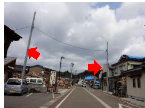
仮設電柱にて応急復旧
