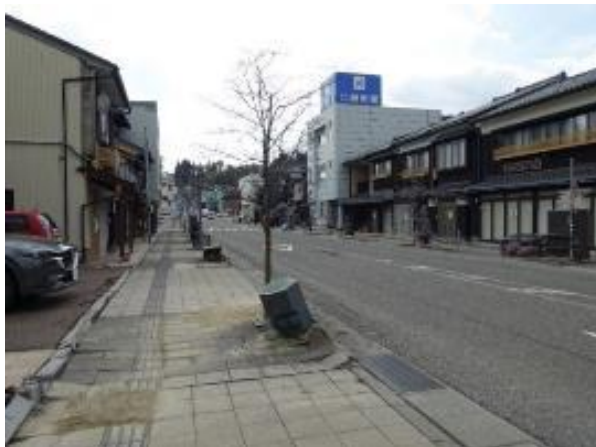
車両通行に支障となる被害はない
