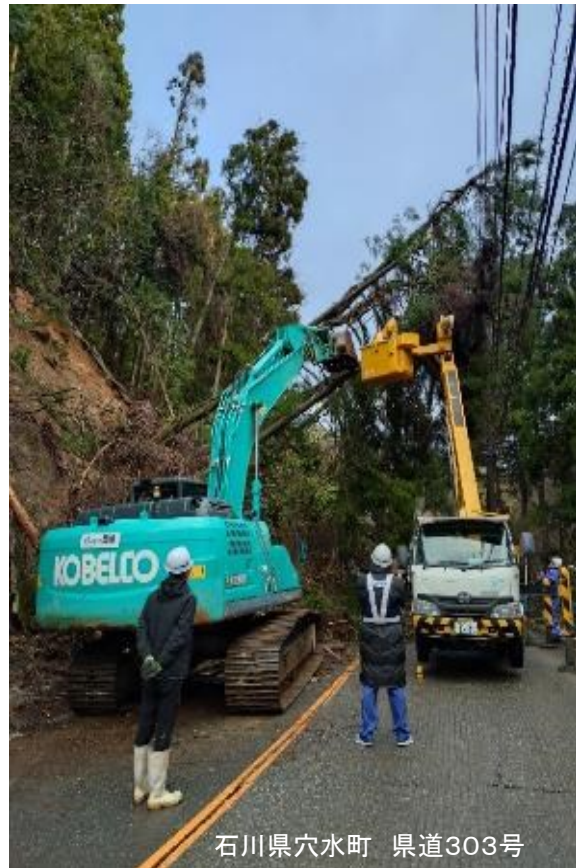
【電線に接触した倒木の処理(能登半島地震)】
