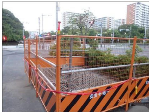
港湾局大井2号 (電線共同溝工事)
