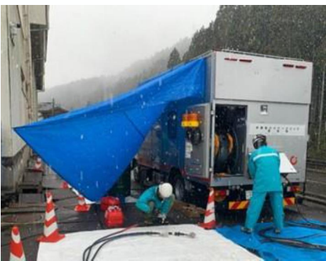
電源車から避難所への 送電作業の様子 （中部電力パワーグリッド）
