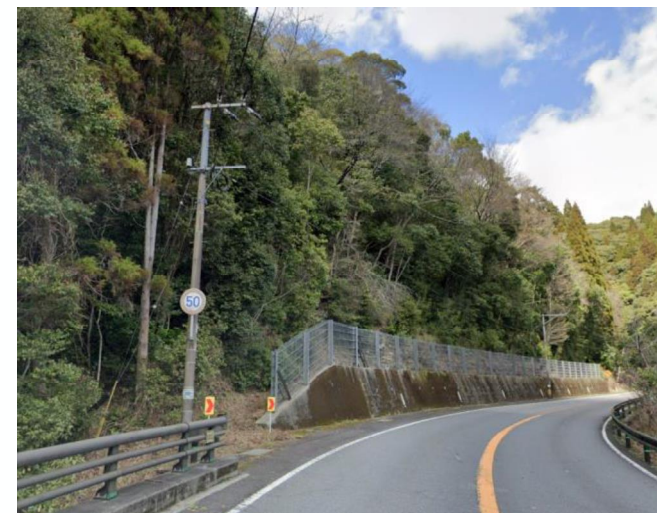
＜大分県擁壁部＞
