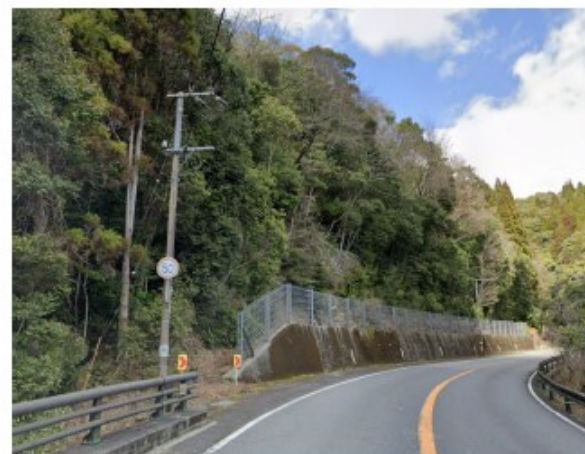
＜大分県擁壁部＞
