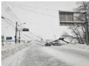
【令和4年12月 暴風雪による電柱倒壊状況】 (北海道幕別町)
