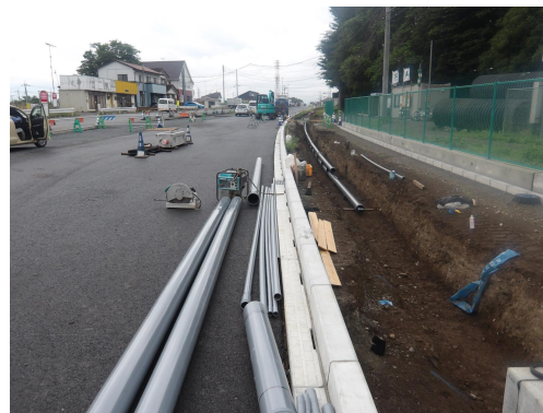
街路事業【県道前橋長瀬線(高崎市)】
