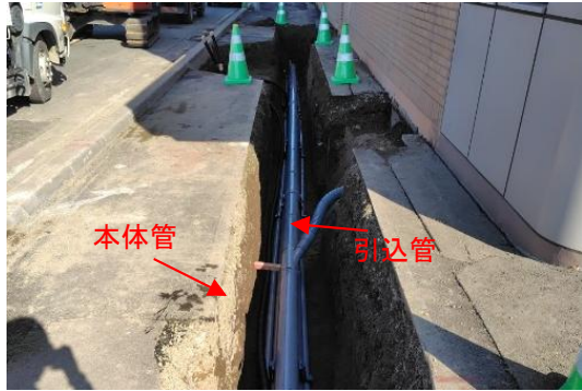
本体管と連携・引込管の同時施工
