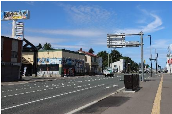
速やかな電柱撤去
