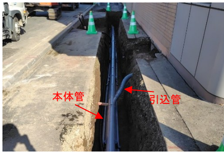
本体管と連携・引込管の同時施工
