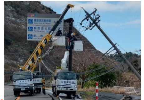
道路啓開作業
