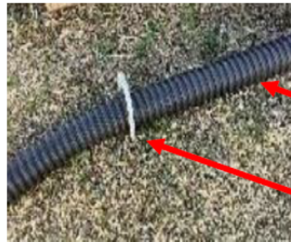
<地上に施設する電線路のイメージ>
