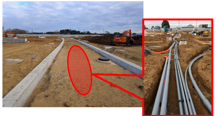
無電柱化まちづくり促進事業を活用した無電柱化の実施事例(千葉県芝山町)
