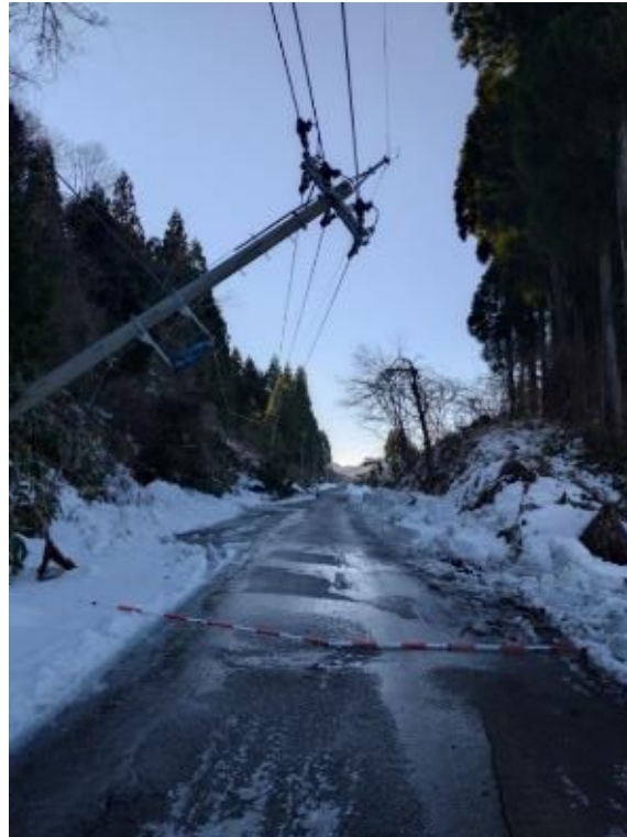
石川県輪島市 広域農道
