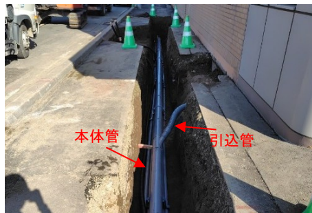
本体管と連携・引込管の同時施工
