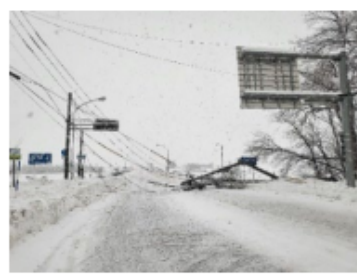
【令和4年12月 暴風雪による電柱倒壊状況 (北海道幕別町)】
