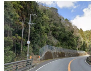
<大分県擁壁部>
