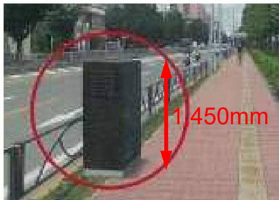
地上機器のコンパクト化事例 (高さ1,450mm ⇒ 800mm)
