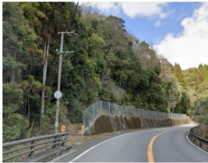
＜大分県擁壁部＞
