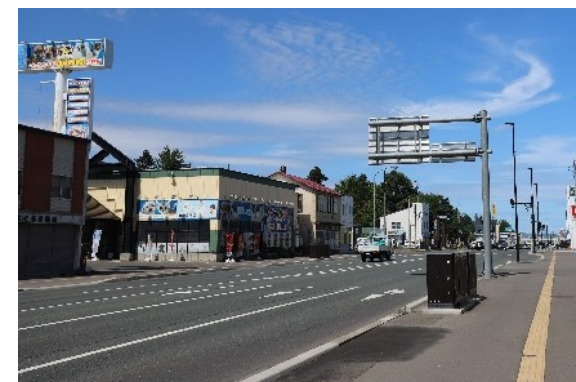
速やかな電柱撤去
