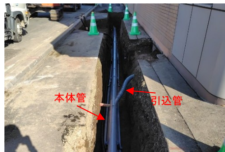
本体管と連携・引込管の同時施工
