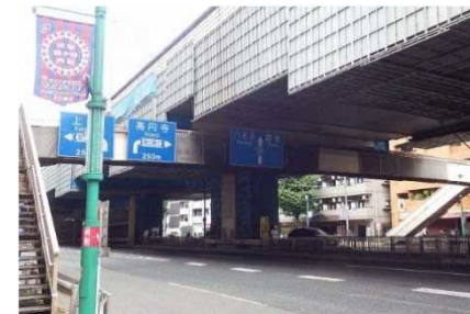
横断歩道橋 (全景)
