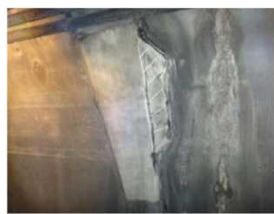
▲トンネル目地部
