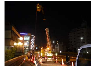
道路照明灯の点検補修
