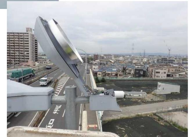
図 国道25号における照明灯具破損・落下事故
