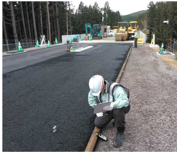
温度計による転圧温度測定
