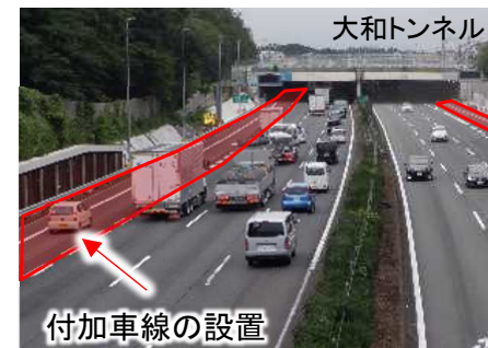
<東名高速大和トンネル付近>
