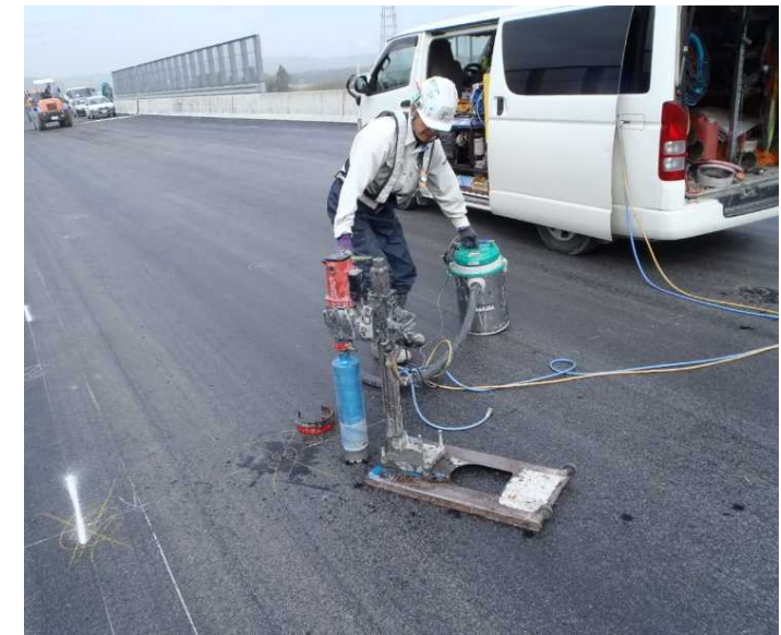
コア採取による舗装の密度管理
