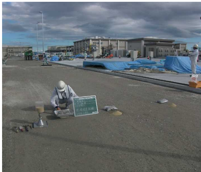
砂置換法による路盤の密度管理
