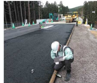
温度計による転圧温度測定
