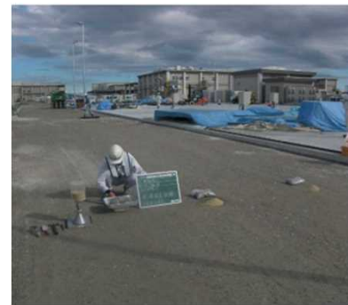
砂置換法による路盤の密度管理
