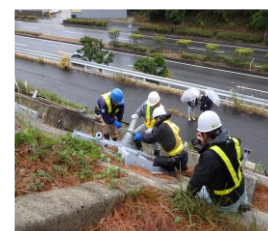
非破壊検査の一例
