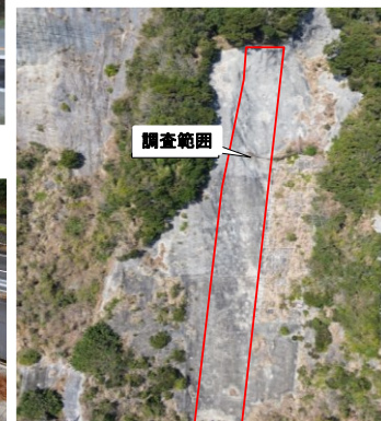
吹付のり面実証実験フィールド
