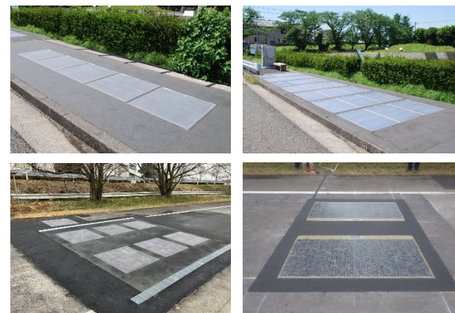
＜性能試験状況＞
