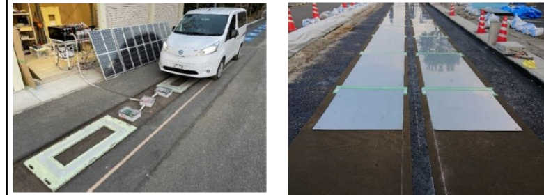
コイル・電極の舗装埋設による給電試験の様子 (左: 東京理科大学居村研究室、右: 大成建設)
