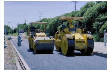
ローラに搭載したGNSSと表面温度計で、
