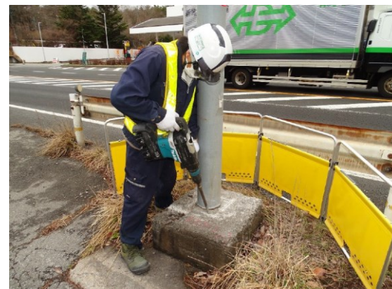
基部掘削の事例
