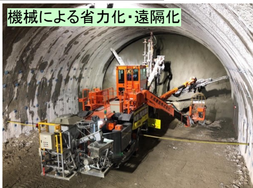
ロックボルト削孔・打設
