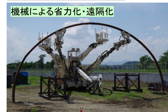
鋼アーチ支保工建込み
