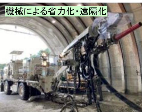
コンクリート吹付け
