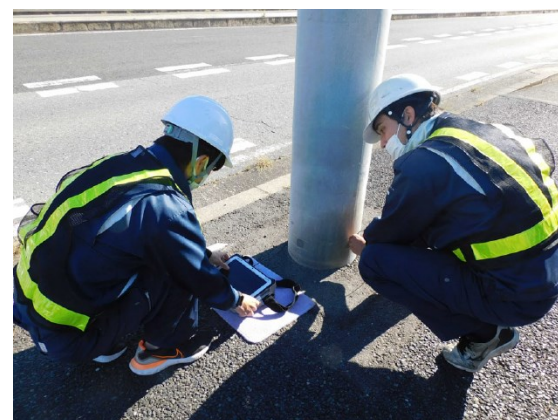
基部非破壊検査の事例
