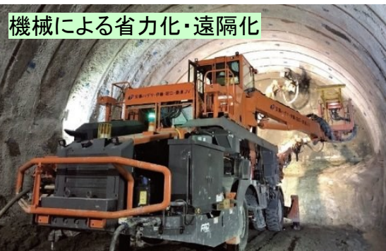
爆薬装填のための削孔
