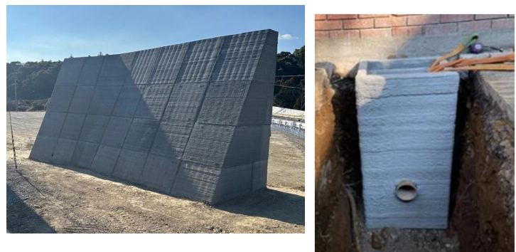
施工例(左 重力式擁壁 右 集水桝)
