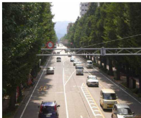
<コンクリート舗装の例>
