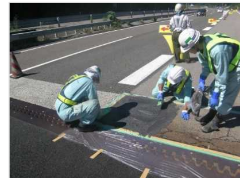
常温混合物による段差補修の例
