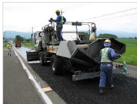
常温混合物による薄層施工の例
