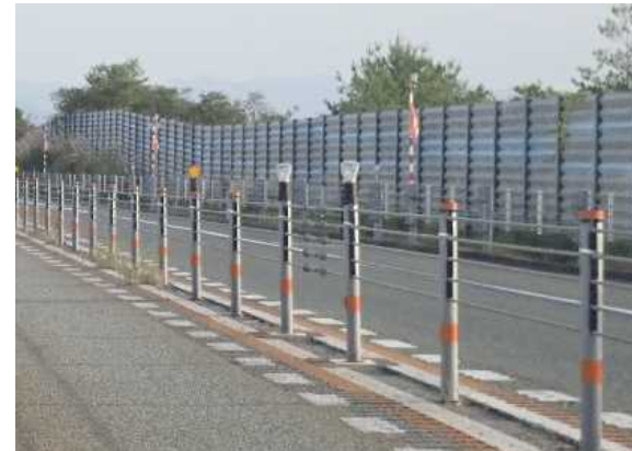
開口箇所 の 光明示 (夜間点滅) (ターンバックル箇所)
