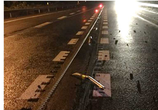
突破箇所の状況
