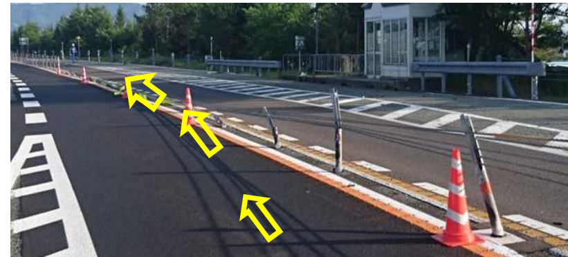
突破箇所状況
