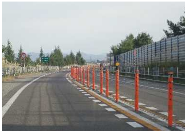
支柱に無反射シール (オレンジ)
