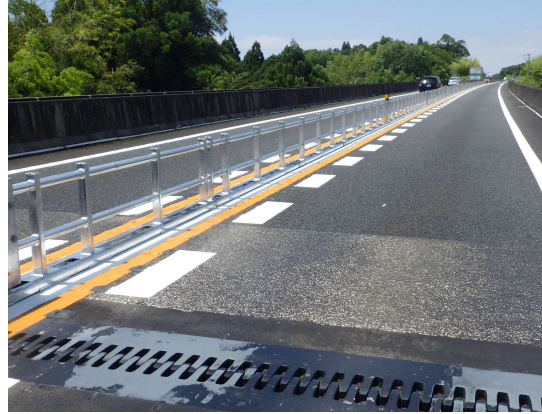
へだがわ E10 東九州道 平田川橋
