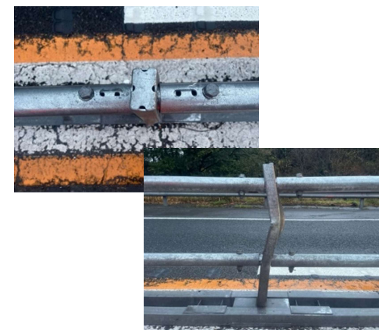
区画柵損傷状況 (端末部:1スパン)
