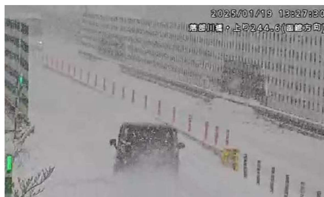
②橋梁手前の時点でふらつき
