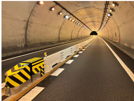
はりき E56 高知道 針木トンネル
