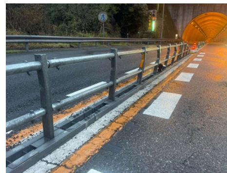
区画柵損傷状況 (端末部:1スパン)
