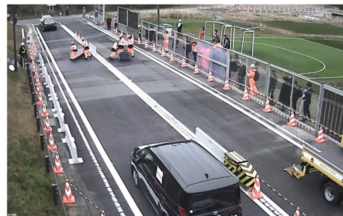
⑥壁部材の8基目の撤去
