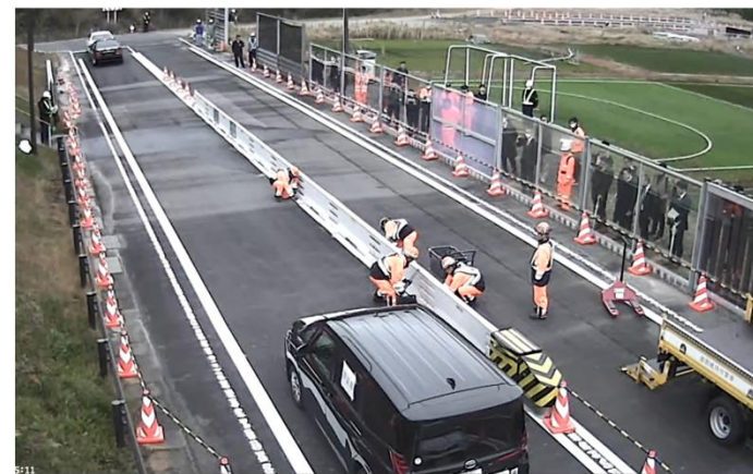
③横連結継手の取り外し
