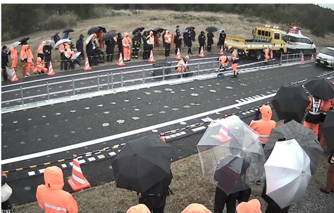
⑤下部レールの取り外し
