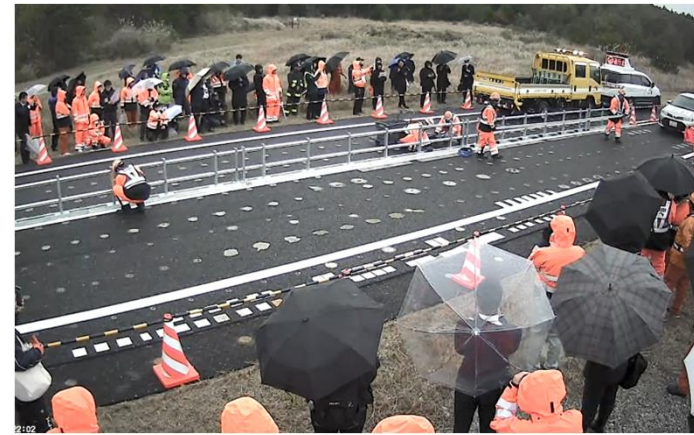
③下部レールの取り外し
