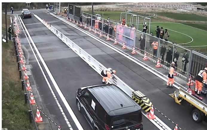
①連結ボルトの取り外し
