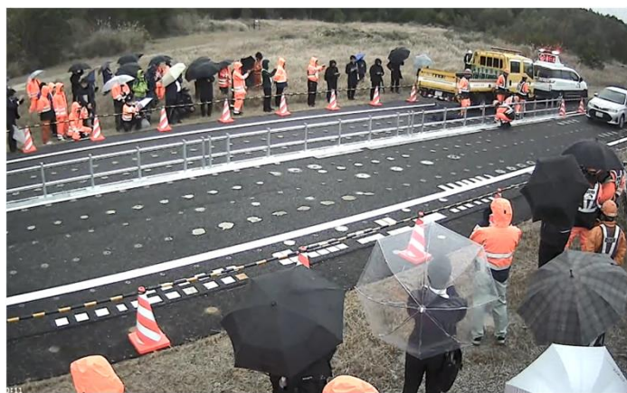
①下部レール固定金具の取り外し
