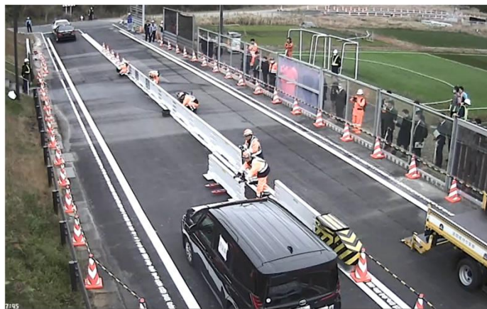
⑤壁部材1基目の撤去
