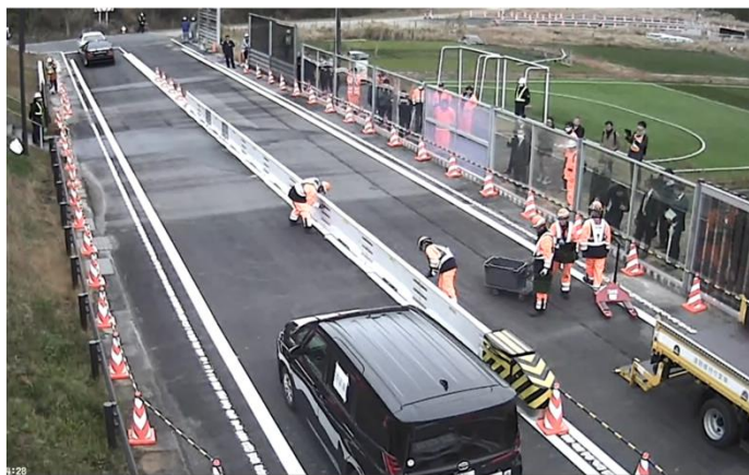
②反対側の連結ボルトの取り外し
