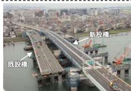
新設橋のスライド架設状況(高速大師橋)
