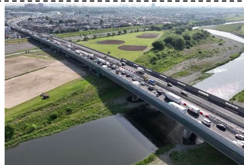
老朽化したコンクリート床版の取替(東名多摩川橋)
