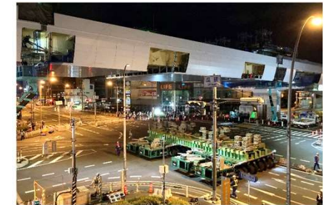
桁の架設状況
