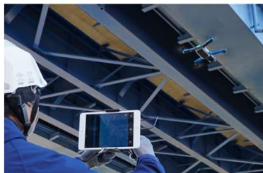
ドローンによる点検
