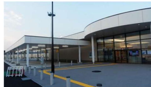
施設の段差解消
