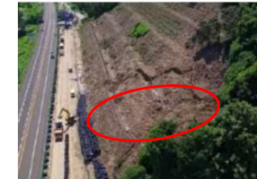
<関越自動車道上越線> 信濃町IC～上越JCT
