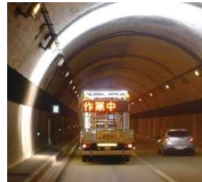
トンネル覆工撮影状況
