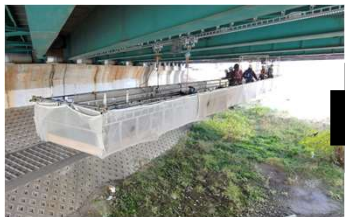
従来は点検用に仮設足場を設営
