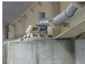
木山川橋 主桁の移動
