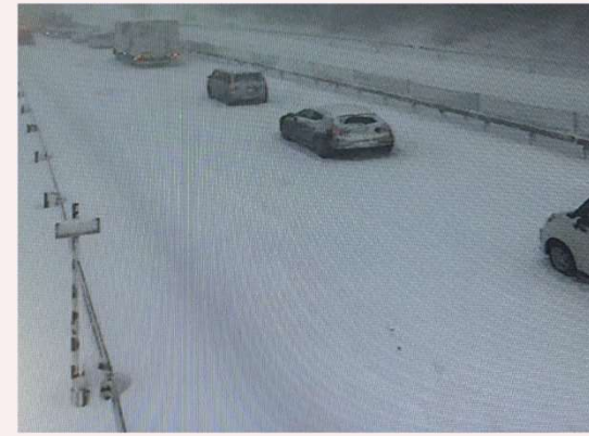
米子道スタック発生状況(令和2月7日)
