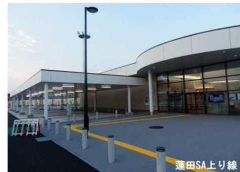
施設の段差解消
