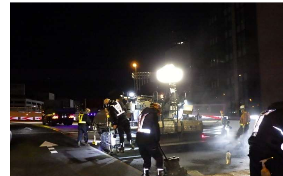
計画的な舗装補修
