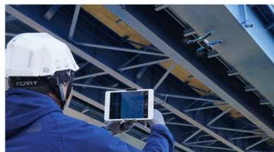
UAV使用による点検状況
