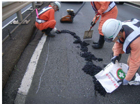
緊急応急状況(舗装の応急復旧)
