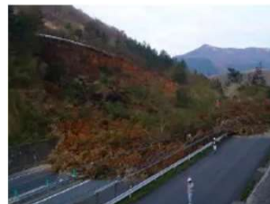
大分道 切り土のり面崩落
