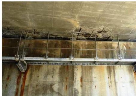
橋台部 塩害損傷
