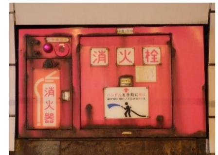
トンネル消火設備 老朽化
