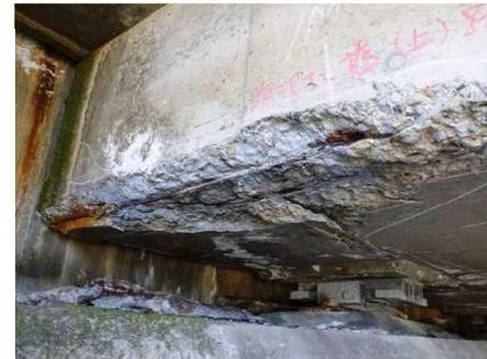
コンクリート桁端部 塩害損傷
