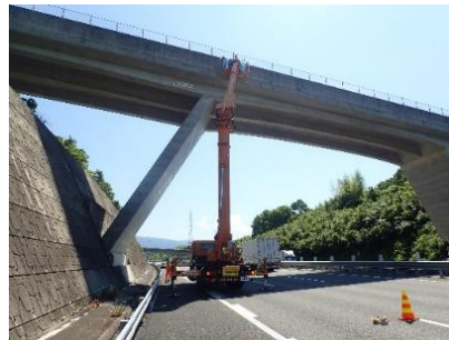
跨道橋の点検
