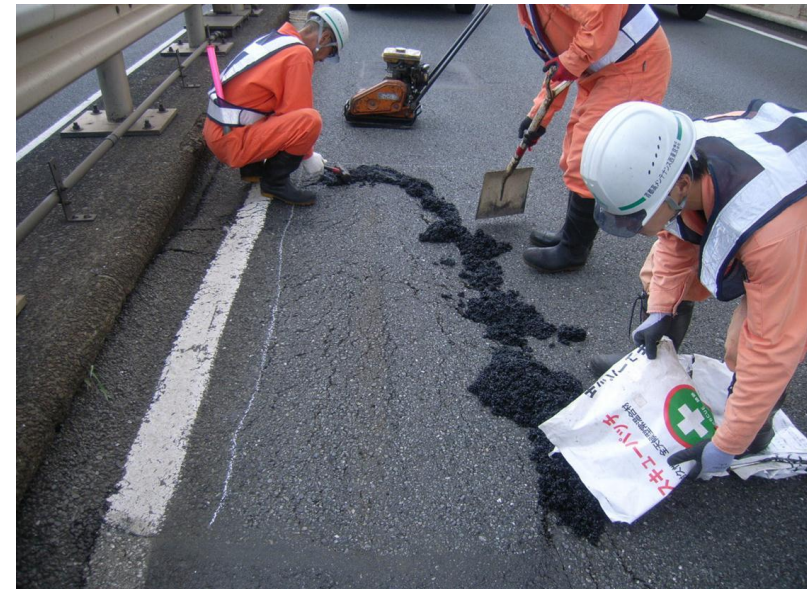
緊急応急状況(舗装の応急復旧)
