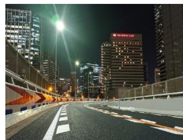
道路照明のLED化
