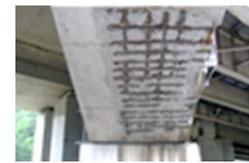
下部工鉄筋腐食・コンクリート剥離
