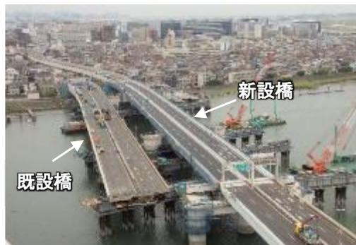
老朽化したコンクリート床板の取替(東名多摩川橋) 新設橋のスライド架設状況(高速大師橋)
