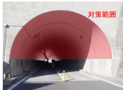
トンネル修繕(炭素繊維補強)
