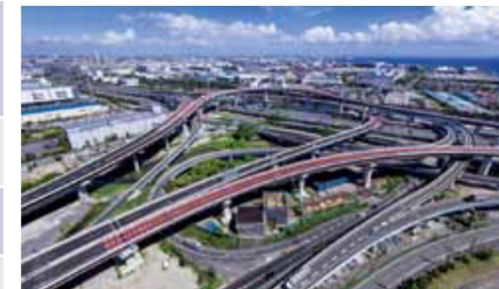
2018.6東京外環道千葉区間開通
