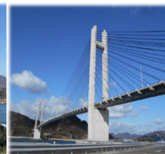
生名橋 (平成23年2月完成)
