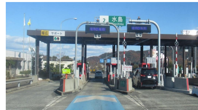
料金所状況(専用化後)
