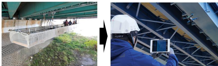
従来は点検用に仮設足場を設営 UAV使用による点検状況
