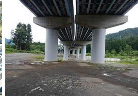
関越道 松川橋
