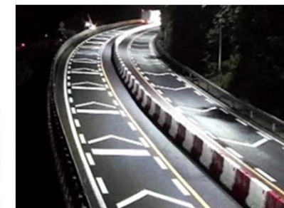
対面通行規制時の 路面標示による安全対策
