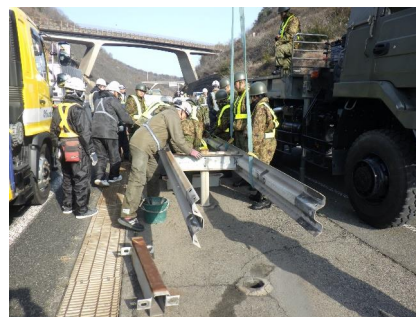
合同訓練(陸上自衛隊第13・14旅団) [中央分離帯非常開口部防護柵撤去]
