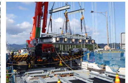
新規伸縮装置の設置状況
