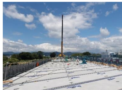
橋梁更新(床版取替)
