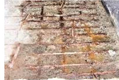
腐食、消失した鉄筋
