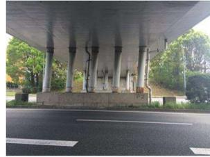
熊本ICランプ橋 橋脚柱傾斜
