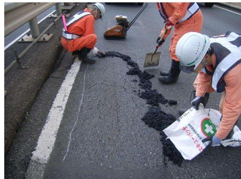
緊急応急状況(舗装の応急復旧)
