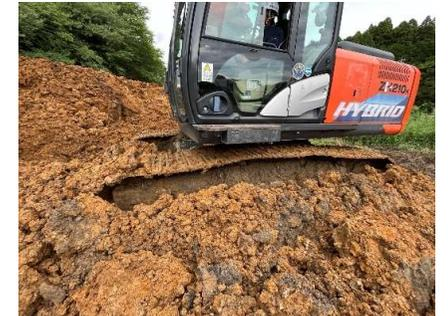
十分な支持力が得られず重機が載ると沈む状態
