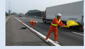
ポットホールの緊急措置
