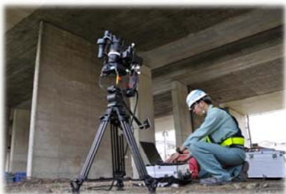
◆点検状況写真
