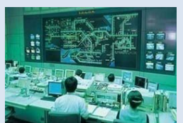
道路管制センター
