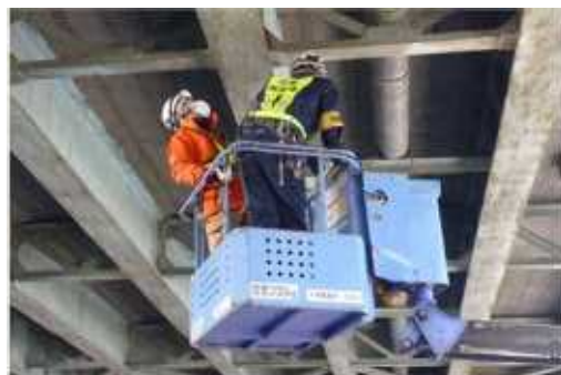
橋梁やトンネルの点検等の業務
