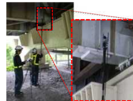
ポールカメラによる点検
