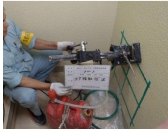
建物耐震診断の現地調査状況
