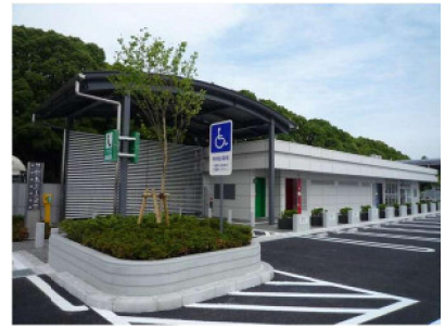
大井東PAの改修
