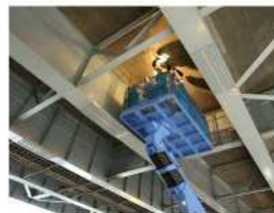
高所作業車による点検
