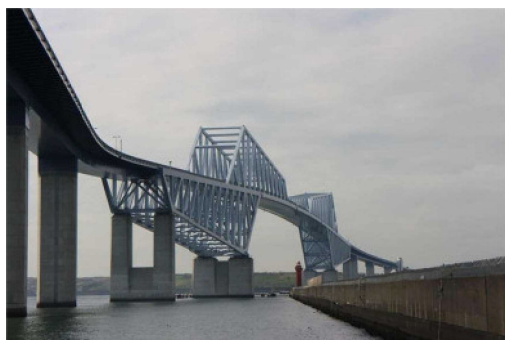
東京都管理の東京ゲートブリッジ橋梁点検業務
