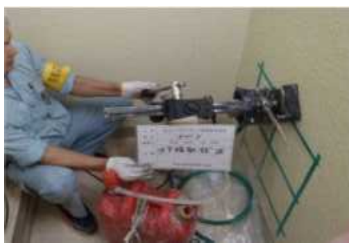
建物耐震診断・補強設計業務 (現地調査状況)
