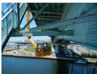
橋梁 定期点検
