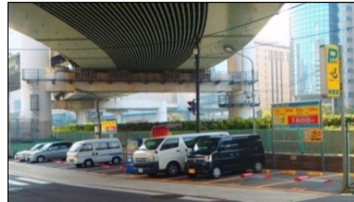
〔駐車場事業(堂島川駐車場)〕
