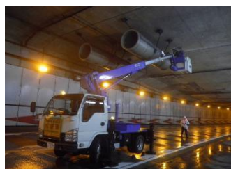
トンネル換気設備 定期点検
