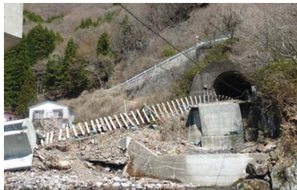
南リアス線 釜石市唐丹(吉浜荒川橋)
