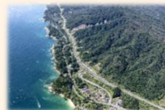
三陸沿岸道路(岩手県山田町)
