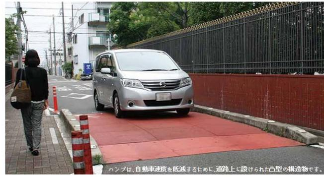
ハンプは、自動車速度を低減するために、道路上に設けられた凸型の構造物です。
