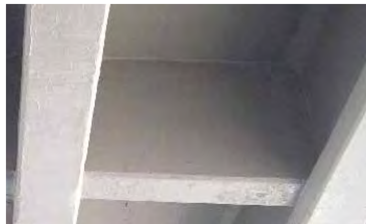
補修後の状況
