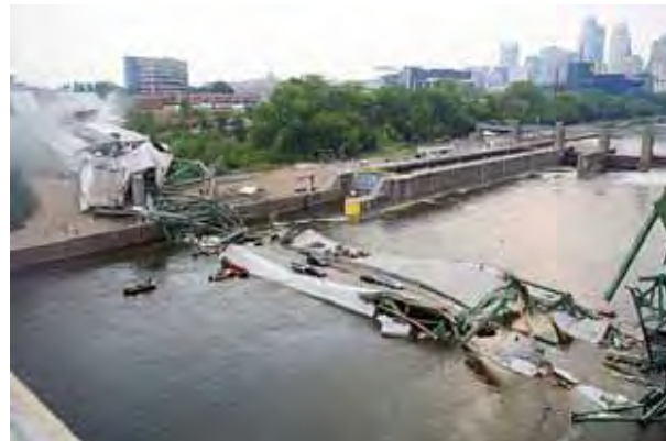
崩壊後の橋梁
