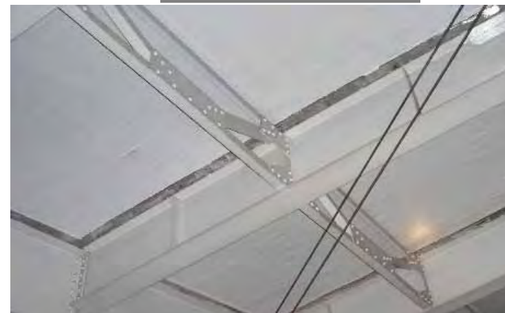
補修後の状況
