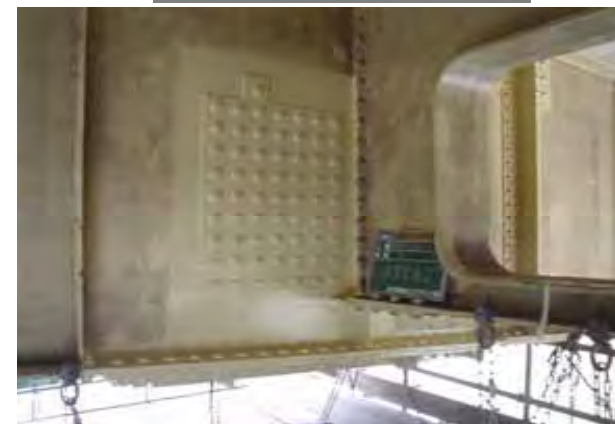
あて板による応急対策
