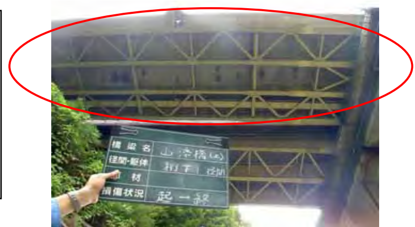
桁下の状況(P1 - P2)
