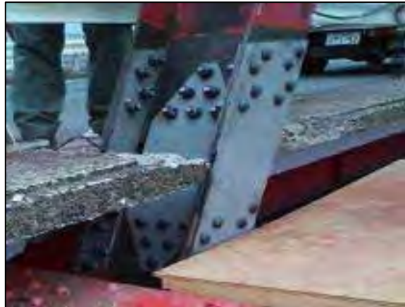
補修後の状況
